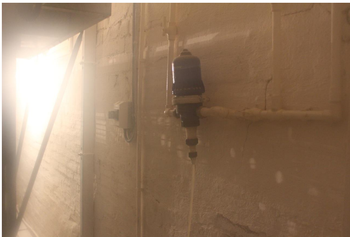
Рисунок 25 - Санация системы поения специальными щелочными средствами при помощи медикатора «Дозатрон»
